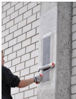
(a) Einarbeiten in Epoxidharz
